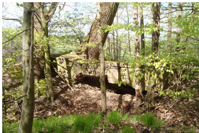
Brückentorso wenige Meter weiter
